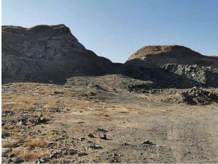
图 3-2 露天采场现状照片
